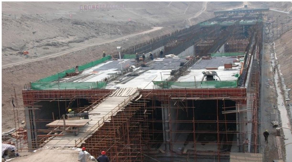
南水北调防腐内衬工程施工。
